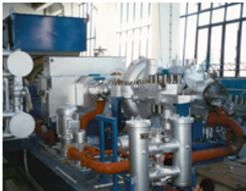
Ceske Budejovice, Чешская Республика, противодавленческая турбина мощностью 29 МВт для городской отопительной ТЭЦ.
